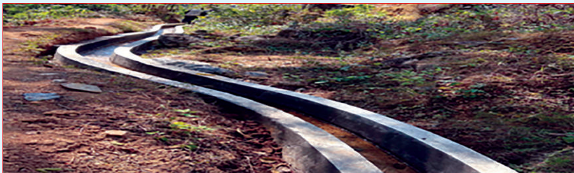
कफी विकास केन्द्रमा निर्माणाधीन सिंचाइ कुलो
